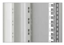
Montážní otvory ve stojinách Otvory v celé výšce stojin odpovídají unitové roztěči vertikálních lišt.
