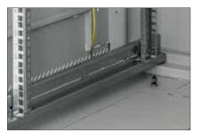
Hlavní zemnící bod M8 V rozvaděči je umístěn šroub M8 pro uzemnění celé instalace.
