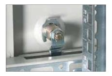
Detail zámku odnímatelné bočnice
